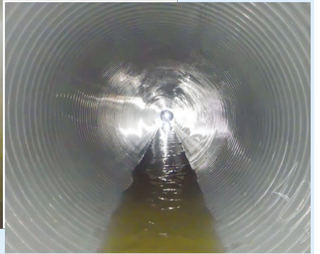
改築工事完了後の下水道管▶
