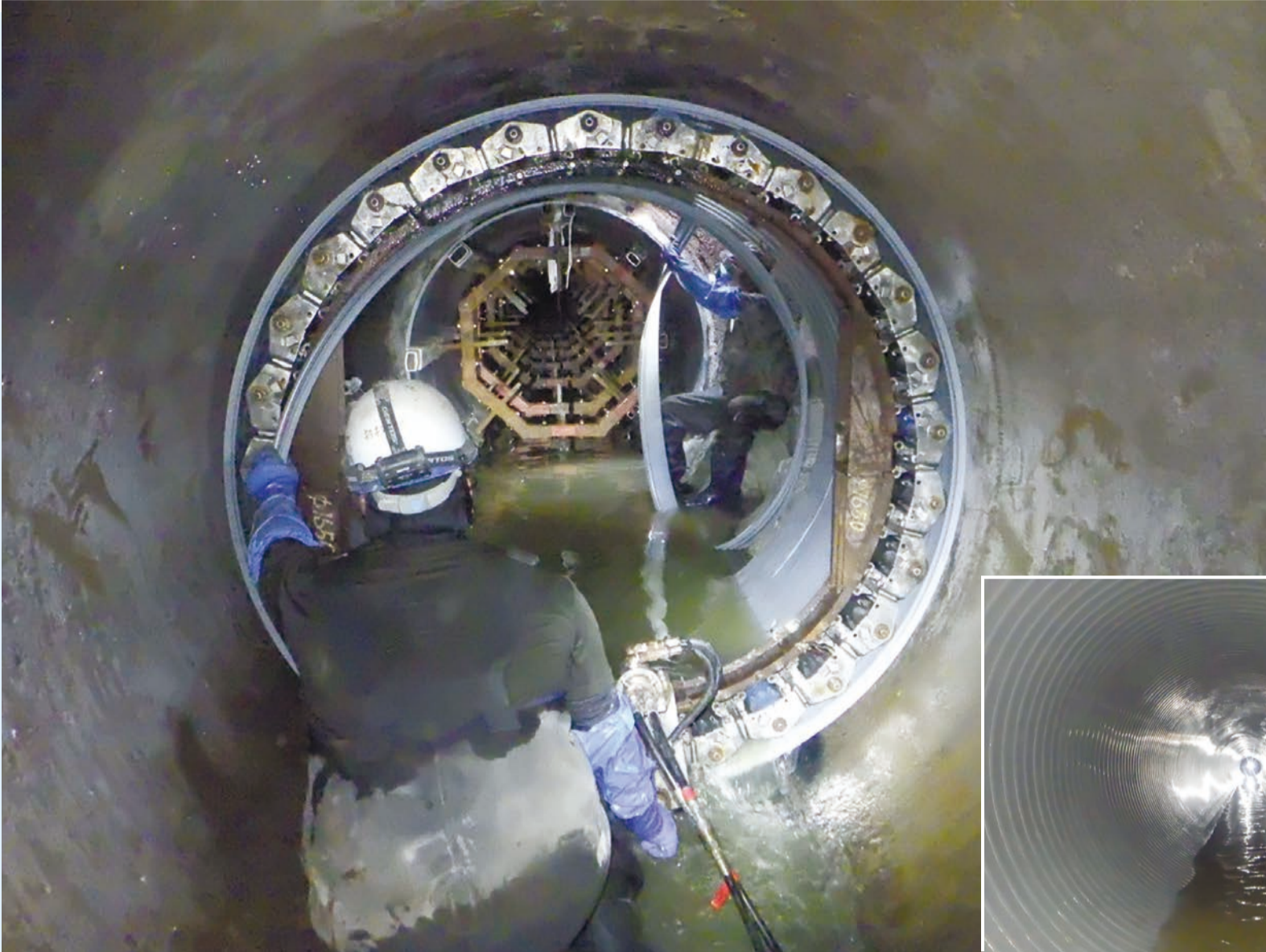
▲改築工事中の下水道管
