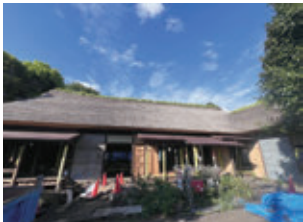
▲旧本田家住宅主屋外観
