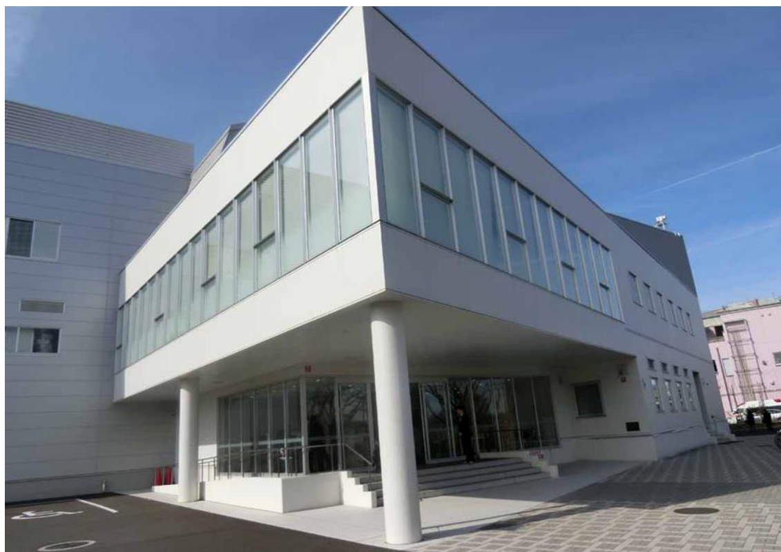
【府中市立学校給食センターの外観(玄関)】
