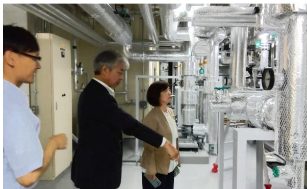
地中熱を利用するためのシステム
